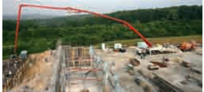
Achsen, ist rund 21 m lang und hat ein maximales Gesamtzuggewicht von 80 t. Der Wendekreis beträgt hervorragende 36 m. Wenn die ausfahrbaren Stützen in Position sind und das Fahrgestell entladen ist, dienen Zugmaschine und Auflieger, die miteinander verschraubt sind, als Gegengewicht für die Pumpe. Die fünf Segmente werden hydraulisch ausgefahren.
